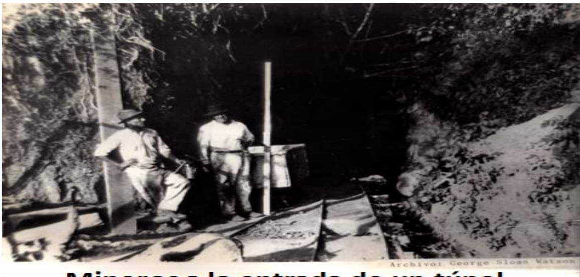
Mineros a la entrada de un túnel
